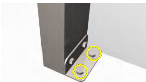
Tarugos de fijación al suelo.
